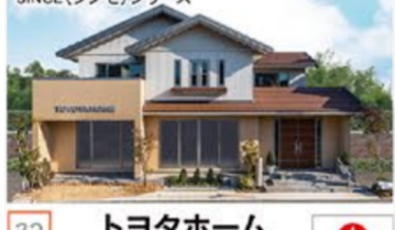
32 トヨタホーム 鉄骨ラーメンユニット工法 TEL.043-274-2821
