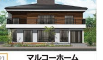
21 マルコーホーム 木造軸組+パネル工法 TEL.043-306-1899
